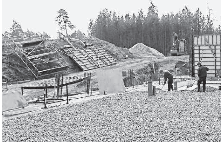
Gründungslösungen mit dem Glasschaumgranulat ermöglichen einen zeit- und kostensparenden Bodenaufbau.
