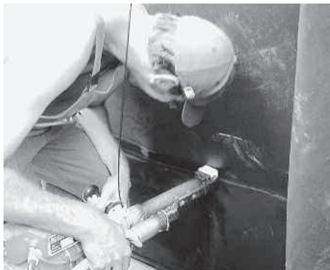
Auch an der Wand wird die ABG-Dichtungsbahn thermisch verschweißt.
