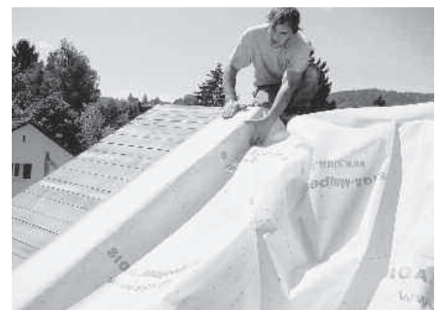
Jetzt geht's doppelt so schnell: Mit der neuen 3-m-Breite von Majpell 5 sparen Handwerksprofis eine Menge Arbeitszeit. In Kombination mit der bewährten Größe von 1,5 m ist außerdem eine präzise Materialbestellung der Dampfbremse möglich. Auch fällt weniger Verschleiß an.
