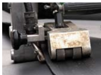
Die ABG-Dichtungsbahn wird mit ihren überlappt verlegten Nähten thermisch verschweißt
