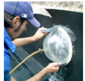
Die Nähte werden zu 100 Prozent mit einer Unterdruck-Saugglocke auf Sicherheit überprüft
